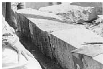
<사진 83> 하대중석 Crack
