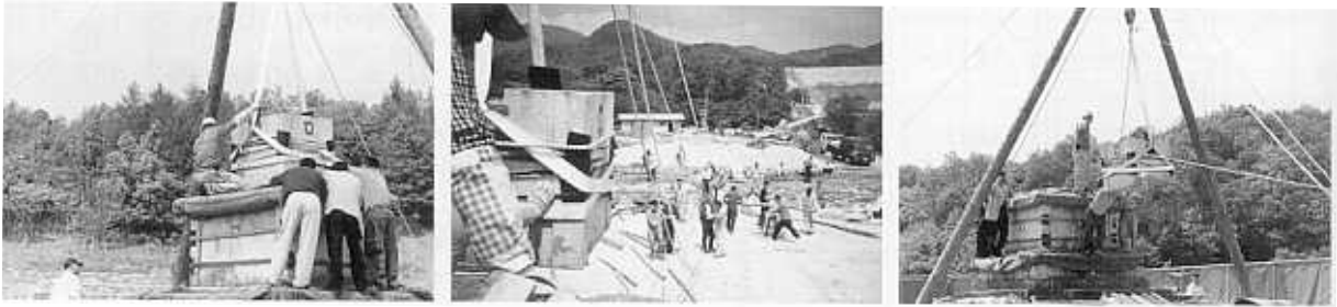
<사진 44> 1층 탑신 해체과정 1 <사진 45> 1층 탑신 해체과정 2 <사진 46> 1층 탑신 해체과정 3
